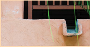
RC Gutter 钢筋混凝土排水槽
